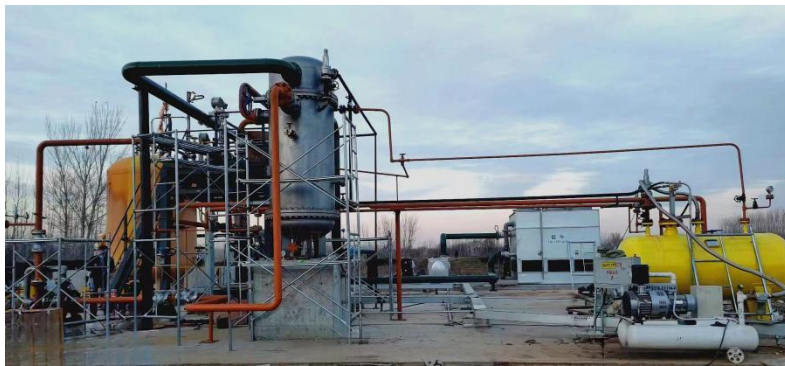
雄安示范工程现场照片（2022.12）
