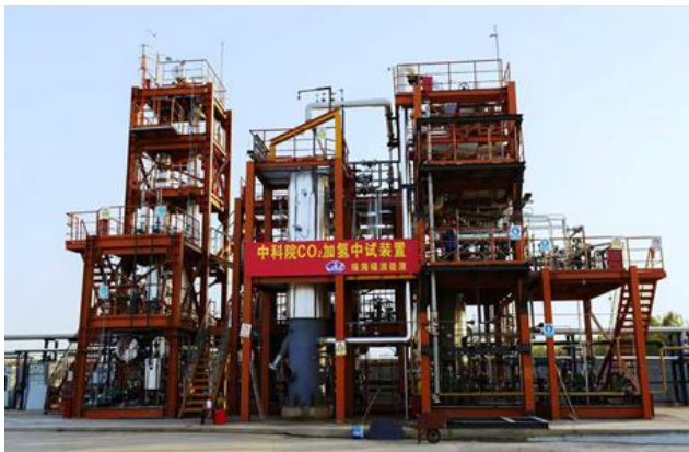
千吨级二氧化碳加氢制汽油中试装置
